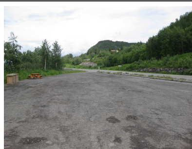
Eksisterende innkjøring sett mot nord.
