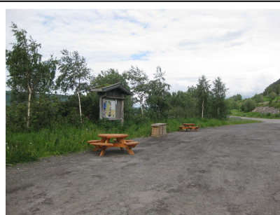
Eksisterende rasteplass sett mot nord.
