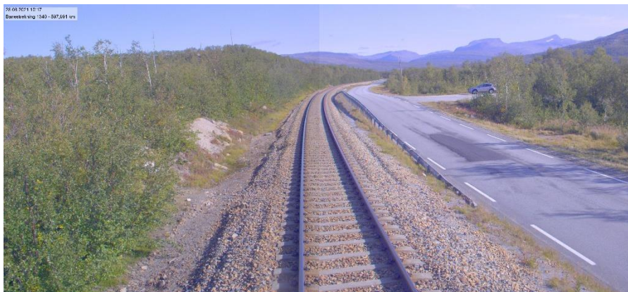
Figur 4-21 Målevognbilde fra NB km 597,991, på strekningen der det er kort avstand mellom jernbanen og E6.
