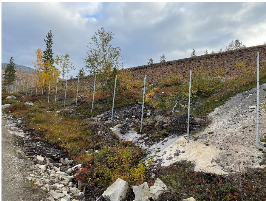
Figur 1-2 Eksisterende sikringsgjerde nord for Lønsdal stasjon.
