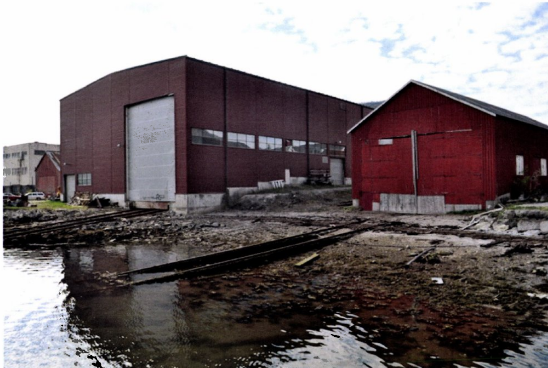
Fjæra er intakt foran Hansennaustet og deler av Saltdalsverftet
