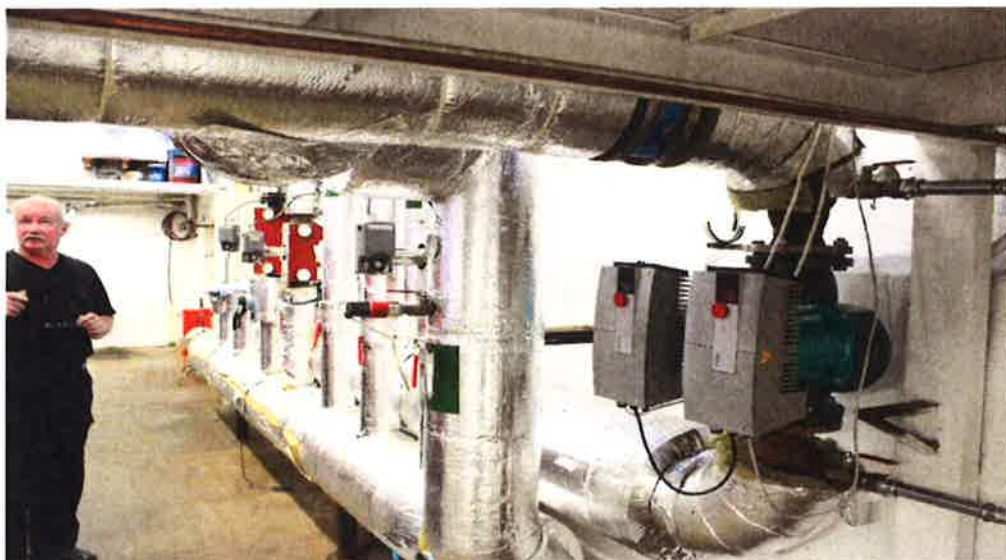
Bilde 1 – Hovedpumpe med samlestock i fyrrom.
