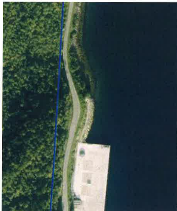
Figur 2-10 Luftspenn på oversiden av fylkesveien.
