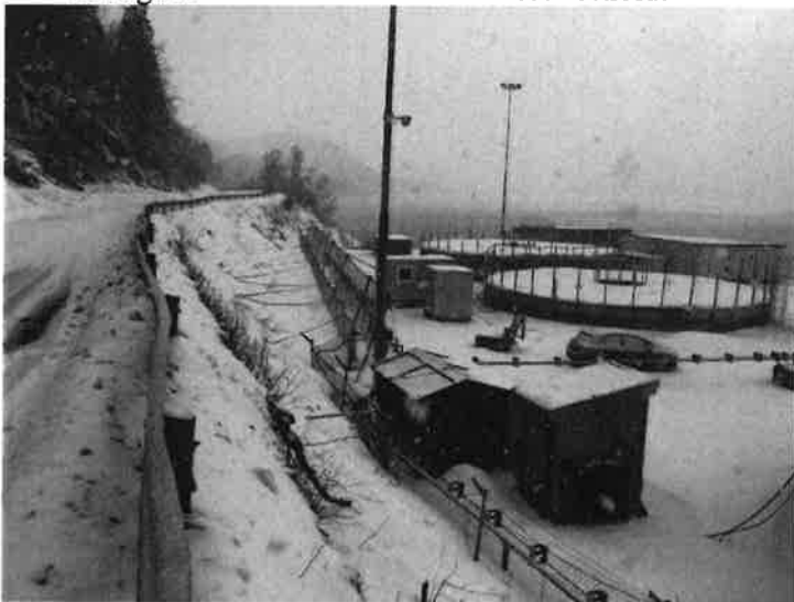
Figur 1 Viser aktivitet på kaia vinterstid. På bildet vises kommunalt pumpehus og trafo. Rasgjerde i front og bakenfor dette er ISPS-gjerde.
