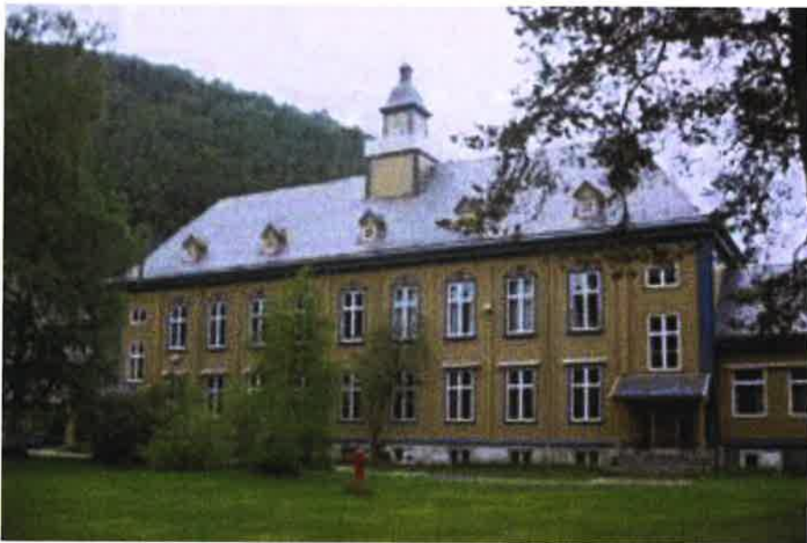
Hovedbygningen på Vensmoen. Tidligere i statlig eie, overtatt av kommunen. Foto: Ingebjørg Hage, Arkitekturguide for Nord-Norge, 2005.
