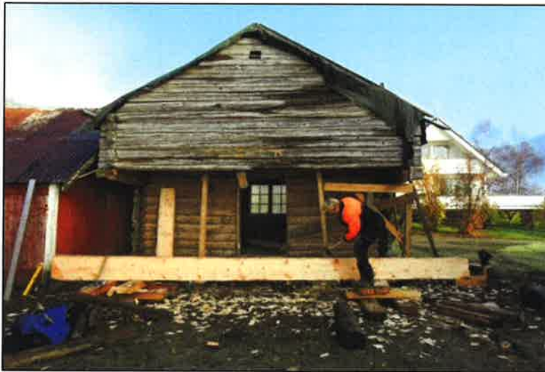
Istandsetting av det fredete stabburet på Øvre Drageid i 2012. Kompetanse i tradisjonshandverk gir bedre bevaring av eldre bygninger, oppdrag for handverkere og salg av materialer. Foto: Bygningsvernprosjektet, Bodø kommune.
