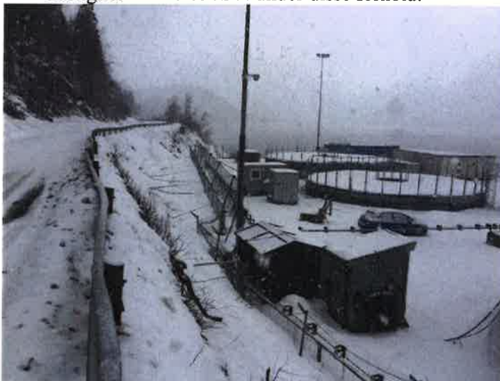
Figur 1 Viser aktivitet på kaia vinterstid. På bildet vises kommunalt pumpehus og trafo. Rasgjerd i front og bakenfor dette er ISPS-gjerde.
