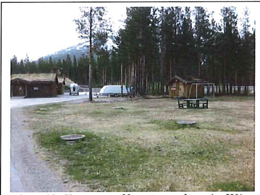
Figur 10: Kummer infiltrasjonsanlegg (o_K1).
