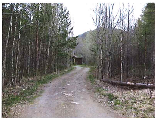
Figur 9: Pumpestasjon avløp sett mot nordøst.
