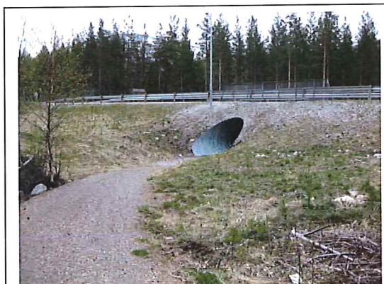
Figur 8: Undergang E6 sett fra GS4.
