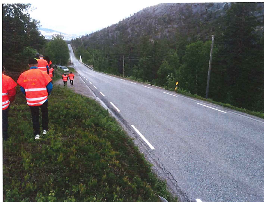
Fig 4-14. Bru over Viskiselva sett mot sør fra ca 8.400m. Veien senkes. Bør sikres med gjerder mellom ny bru og nedskjæring. Se også fig 3-19. Foto M. Selnes, Norconsult.
