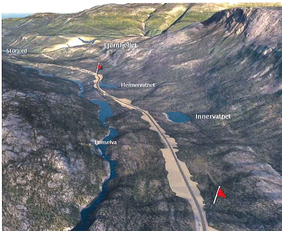
Profil 9 150 – 12 150. Flaggene markerer den omtalte strekningen. De brede feltene langs vegen viser de foreslåtte deponiene for overskuddsmasser.
