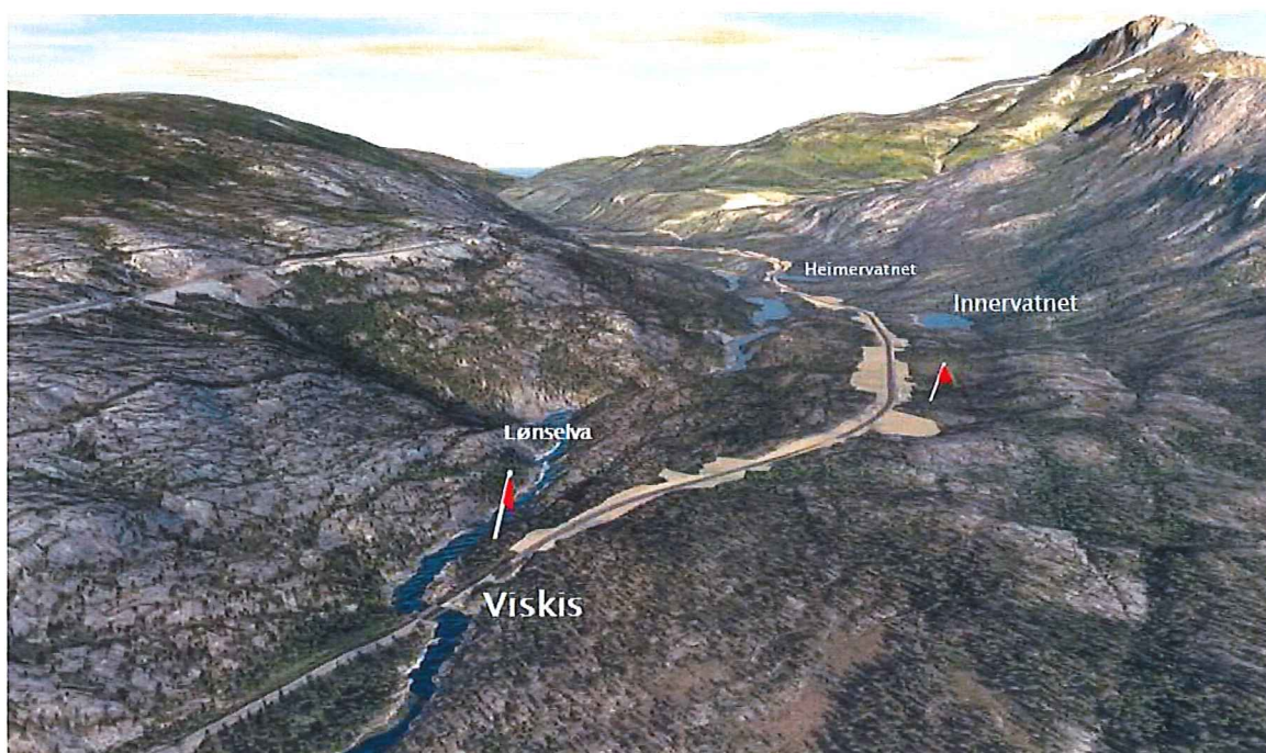
Profil 8 370 (Viskis) – 9 100. Flaggene markerer den omtalte strekningen. De brede feltene langs vegen viser de foreslåtte deponiene for overskuddsmasser.
