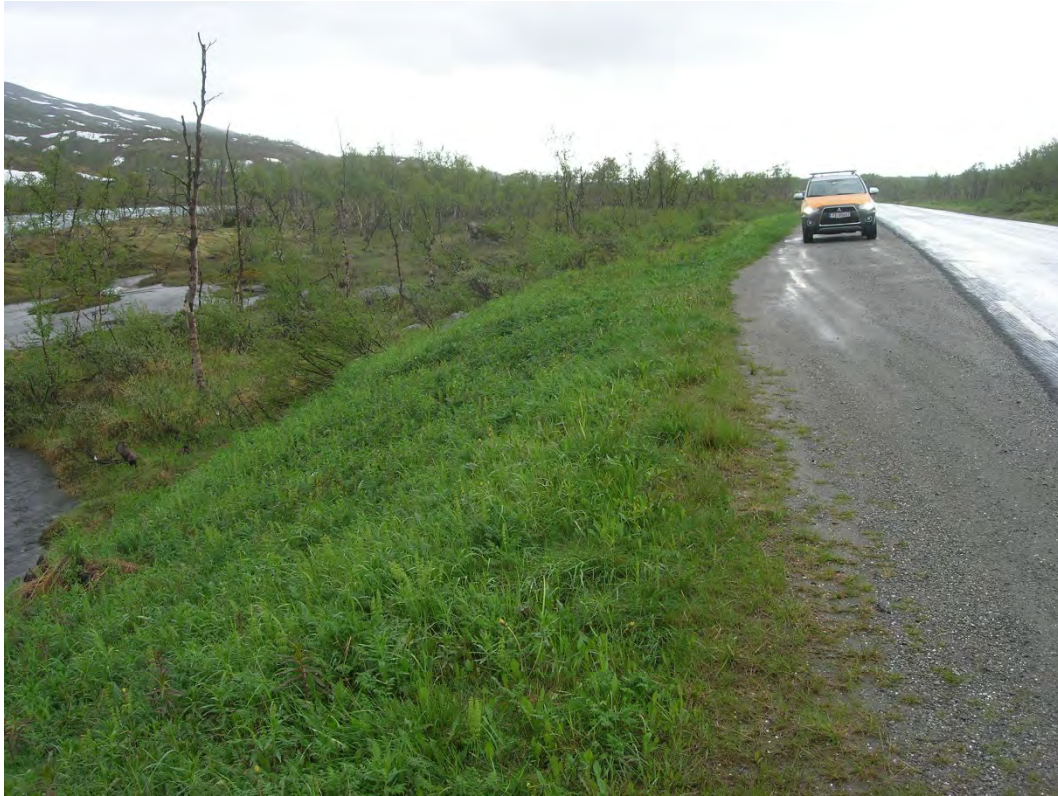
Figur 21 Bildet som viser elva ved punkt 0 og skråningen opp til nåværende veibane. Foto: Statens Vegvesen.
