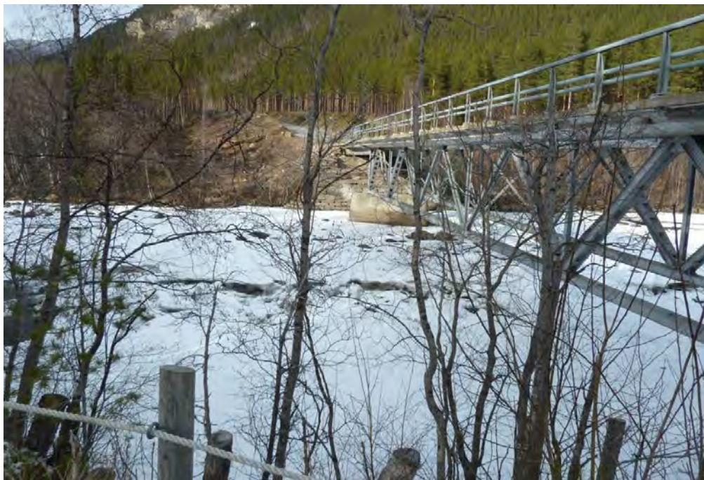
Figur 7 Bildet av eksisterende bru ved Storjord tatt fra sør mot nord.
