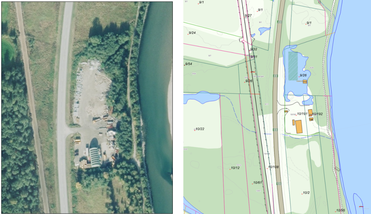
Figur 4: Arealbruken før oppføring av strøsandlager i 2010, nytt bygg vises til høyre
