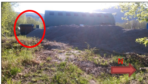
Figur 16: Trafostasjon sør for lagerhallen
