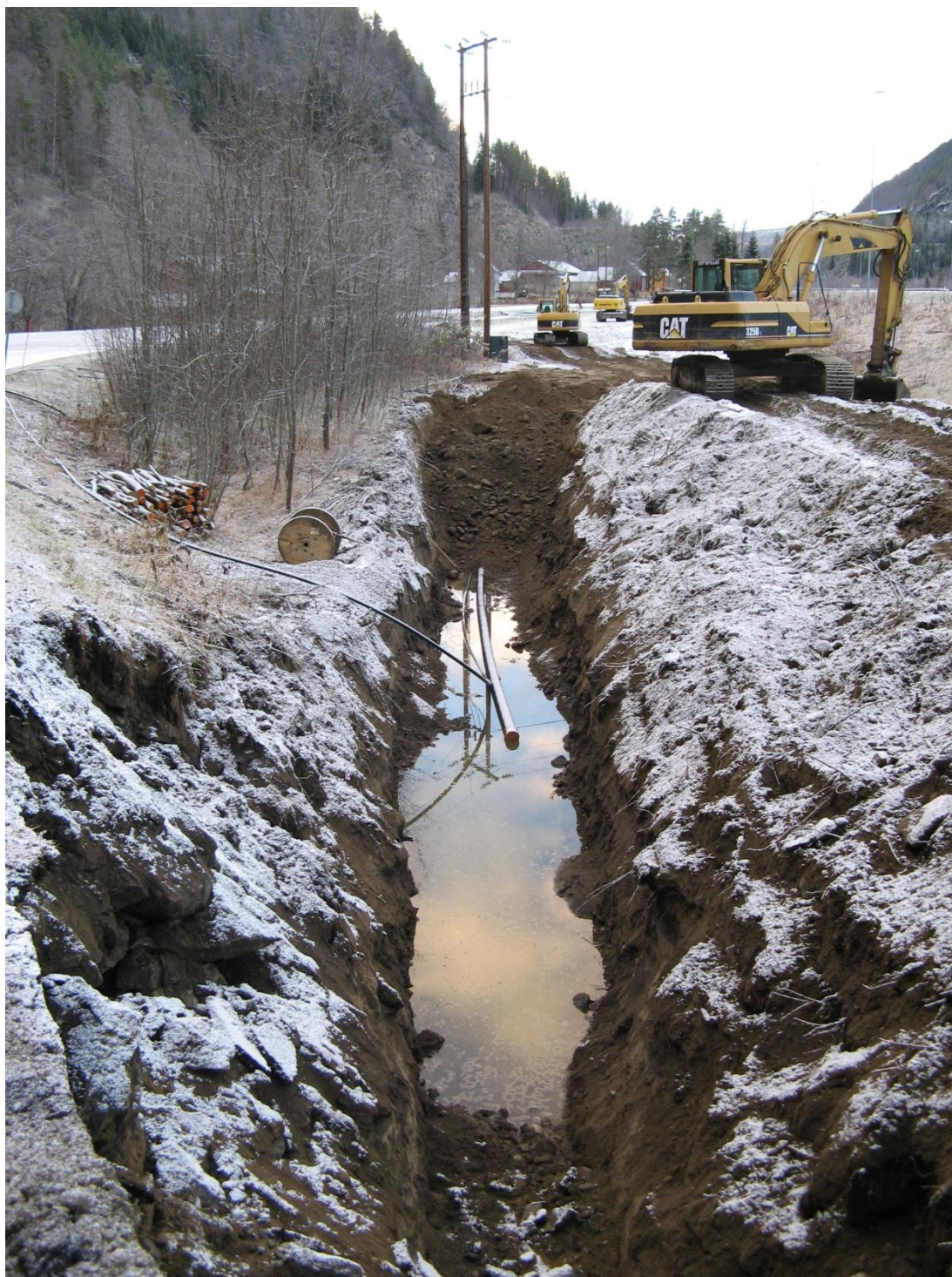
Vann- og avløpsutbyggingen. Foto: Frank Fosheim.
