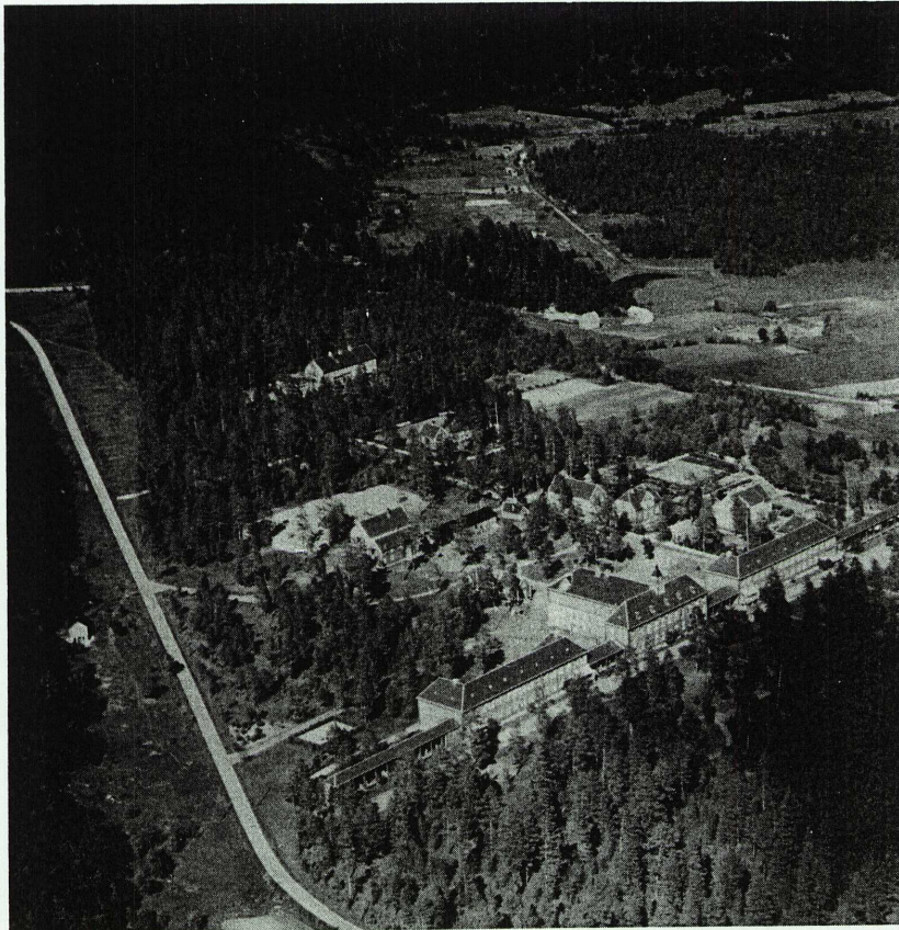
Oversiktsbilde Vensmoen, ca. 1920. Liggehallene mellom hovedbygningen og pasientavdelingene er i en etasje. Barnesanatoriet lengst mot nord.
