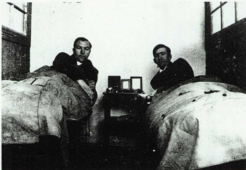
Kuring på Vensmoen. Fra liggehallen mellom økonomibygningen og pasientavdelingen. Bakvegg ibetong.
