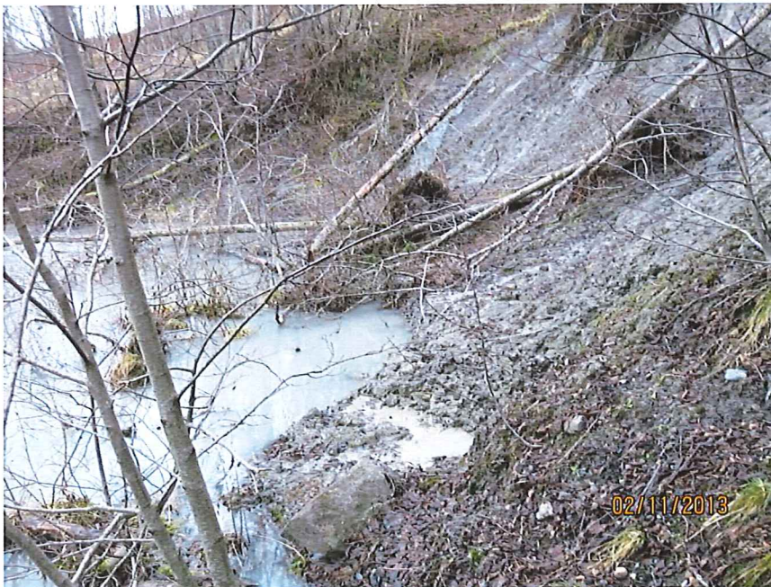
Bilde 6 Utglidninger og erosjon ved B, se fig 4
