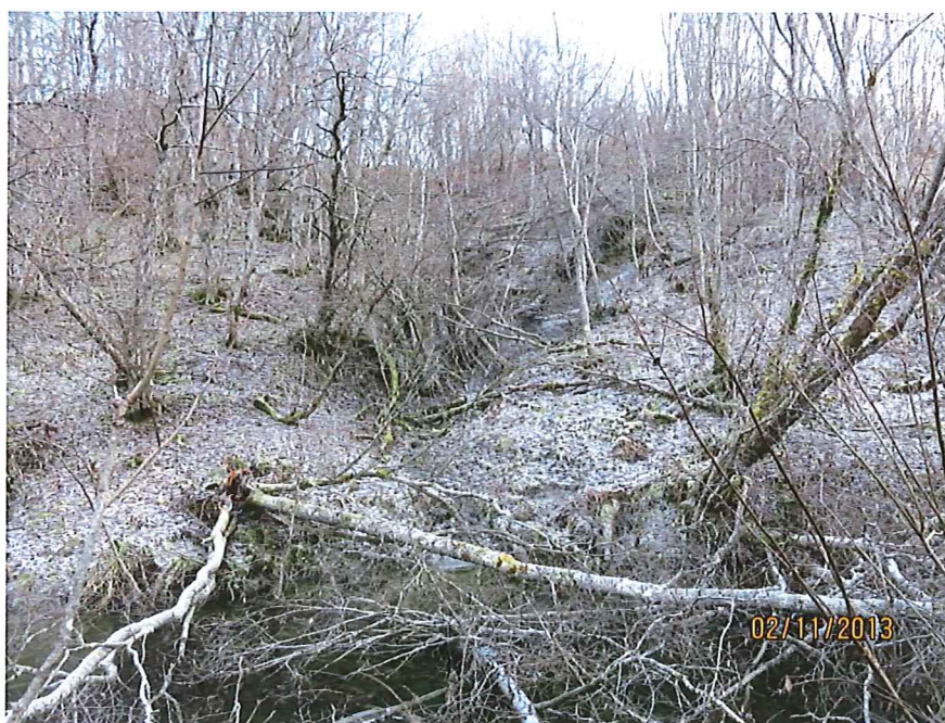
Bilde 11: Utglidningen ved G, se fig 4
