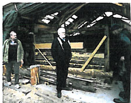
Restaurering av Fjellrosen. Foto: Ole Petter Rundhaug
