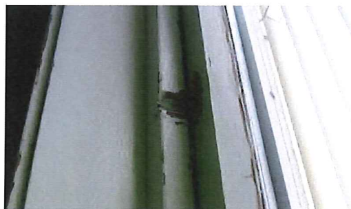
Bilde 21 Mange vinduer i paviljongene er fra tiden det ble oppsatt og har levd sin tid!
