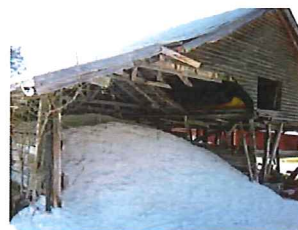
Bilde 30 Åpengarasje, sandlager
