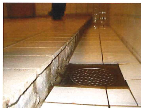
Bilde 3 Uferdig arbeid!
