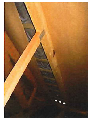
Bilde 20 Krevende reparasjonsarbeid.
