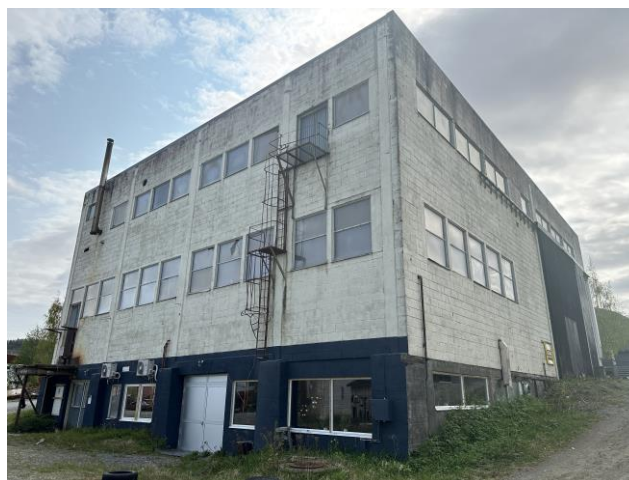
Figur 15 Drageverftet, verkstedhall - sett mot sør
