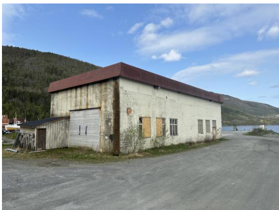
Figur 16 Nerverkstedet - sett mot nord
